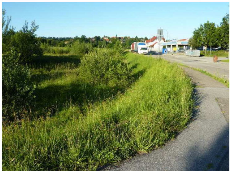
Blickrichtung Nordosten (von Lintacher Straße aus)
